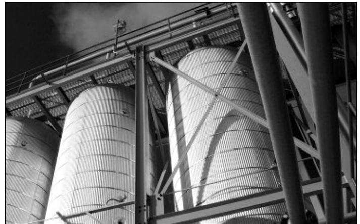
**Biorrefinaria:** instalação industrial para o processamento de biomassa. Da mesma forma que as refinarias de petróleo, as biorrefinarias são fábricas que quebram a biomassa em suas partes constituintes e então as ‘refinam’ utilizando técnicas químicas e biológicas (incluindo a fermentação) para produzir compostos industriais como produtos químicos e combustíveis e também aquecimento e energia.
